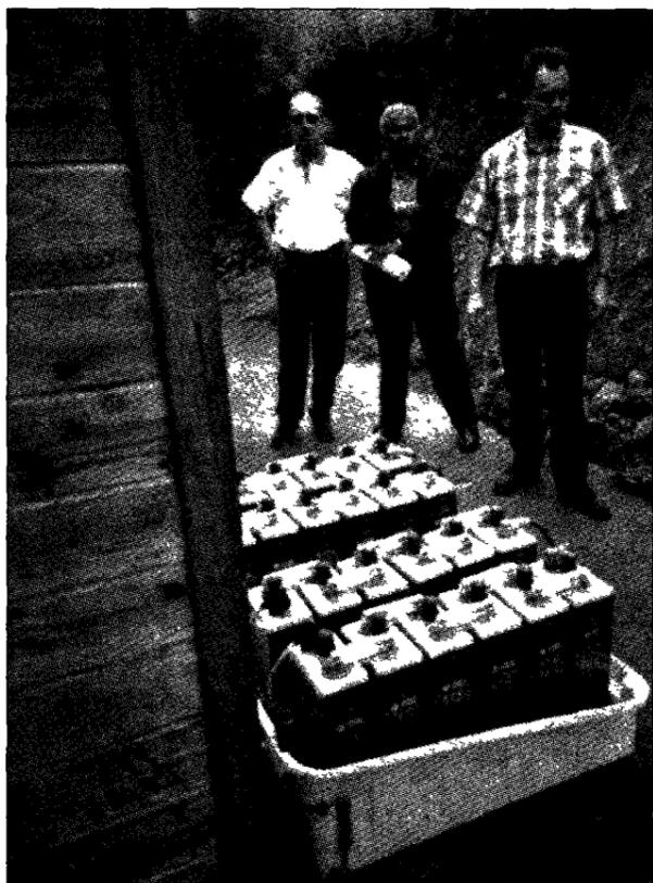
Dans un îlet de Mafate, à Aurère, les batteries d'un gîte qui stockent l'électricité produite à partir du soleil avec les capteurs photovoltaïques.
