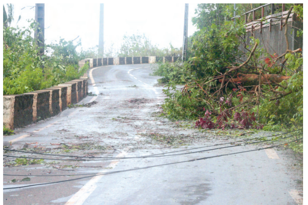
Une des nombreuses lignes électriques coupées suite au passage du cyclone Bejisa.
