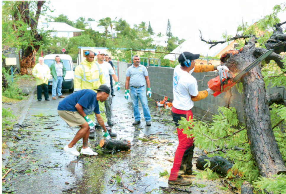
À La Possession, les travailleurs de la commune à pied d'œuvre pour réparer les dégâts.
