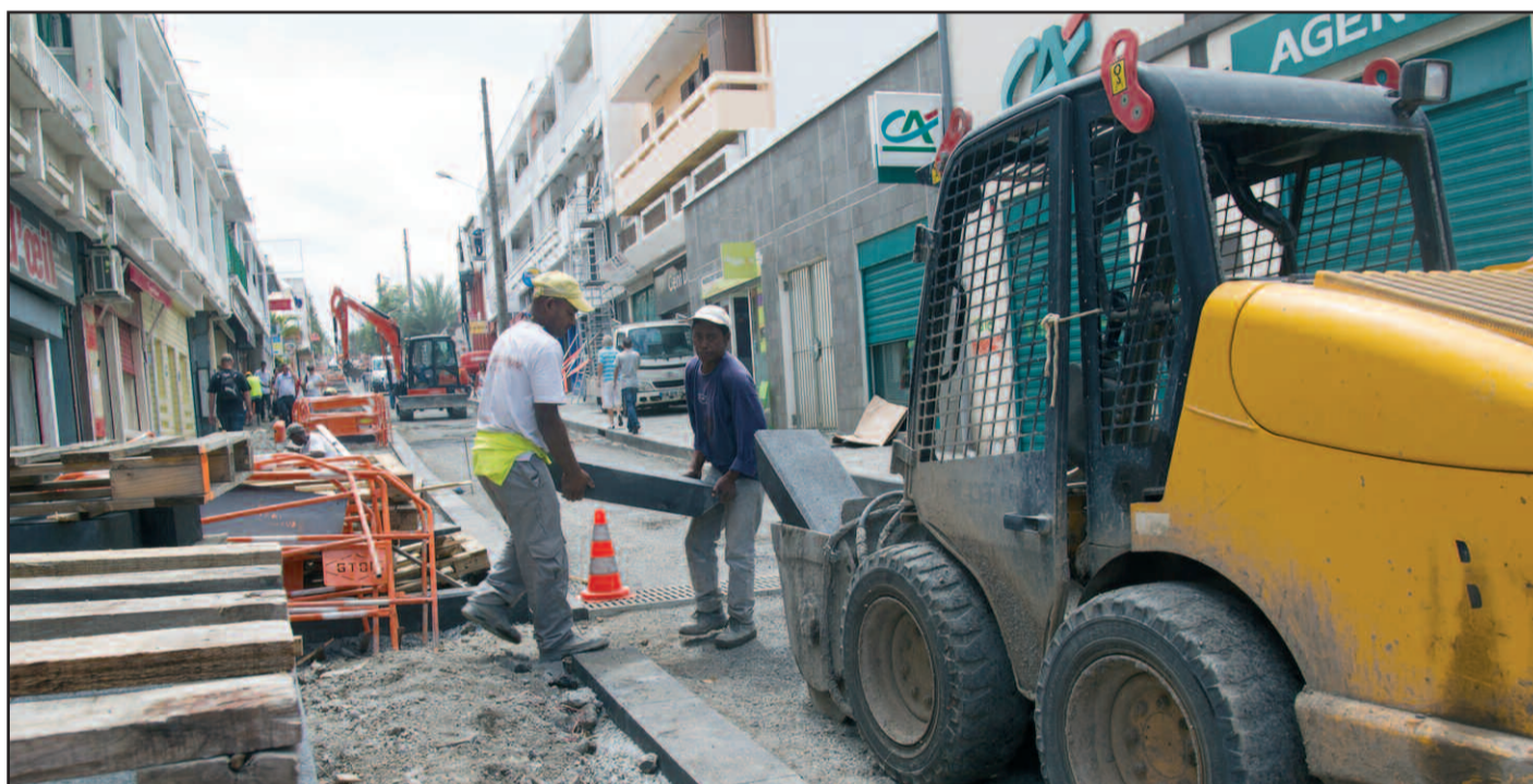
Travaux sur une voirie communale. Comment les Mairies pourront-elles financer des chantiers si la baisse des subventions se confirme. (photo Toniox)
