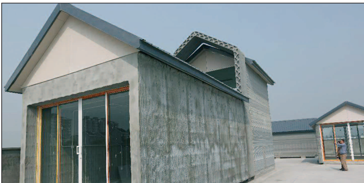
Une maison produite par une imprimante 3D à Shanghai. (photo Xinhua)
