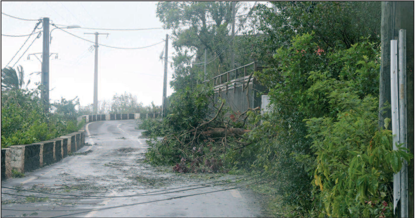
Le dernier cyclone à La Réunion a rappelé la vulnérabilité du réseau électrique aérien dans un pays tropical.
