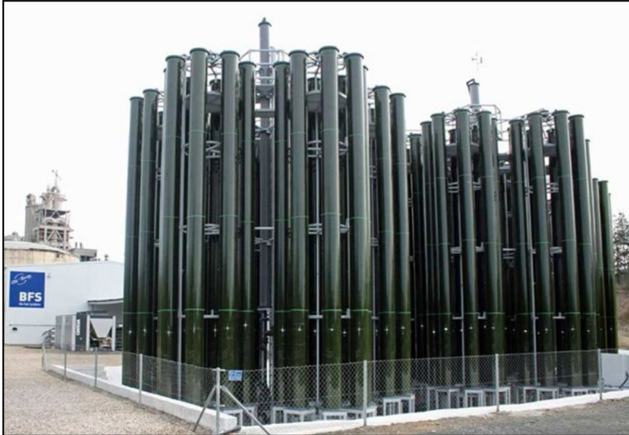
Usine BFS à Alicante.
