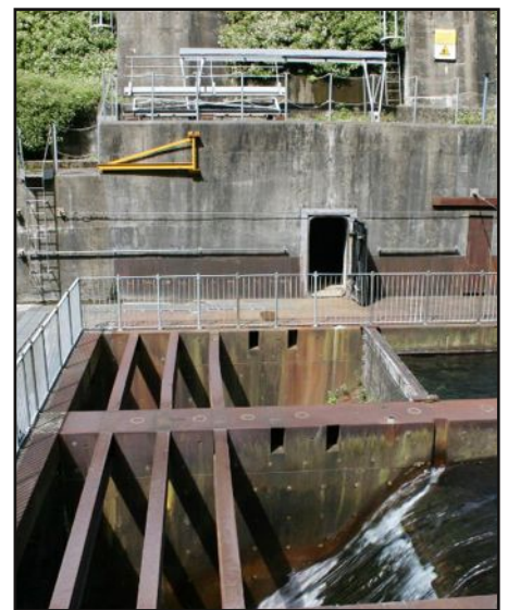
Captage de la rivière de l'Est pour alimenter les réservoirs de la centrale.
