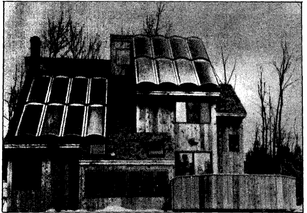
Dans cette maison du Vermont (USA), les capteurs sont surajoutés à la toiture (économie annuelle d'énergie : 65 %).
