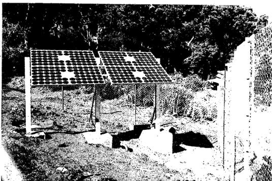
Les deux panneaux équipés de photo-piles captent les photons des rayons du soleil pour les transformer en énergie électrique.
