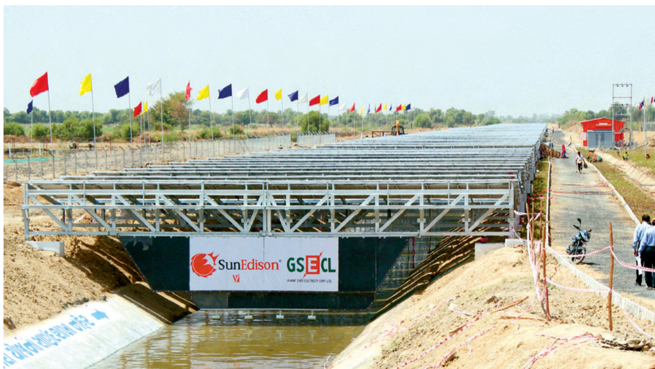
Voici la première tranche du projet: les panneaux solaires sont fixés sur les murs du canal. La centrale n'empiète sur aucune terre agricole, et elle évite les pertes d'eau dans le réseau d'irrigation, au grand bénéfice des paysans.
