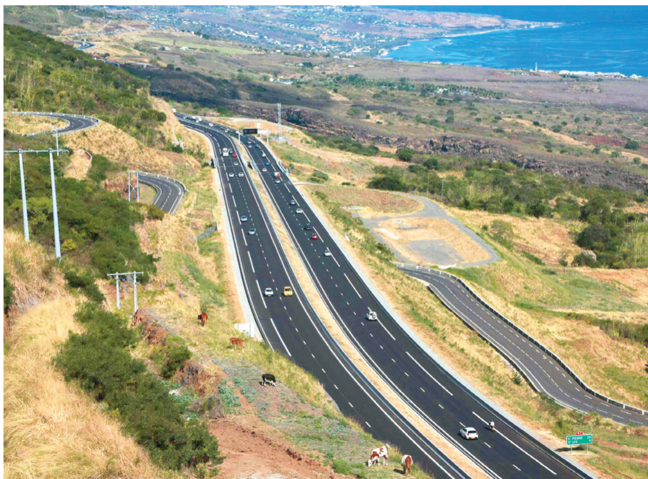
Paul Vergès avait proposé de poursuivre le grand chantier de la route des Tamarins en la recouvrant de panneaux photovoltaïques. Les Indiens montrent concrètement la pertinence de ce projet.
