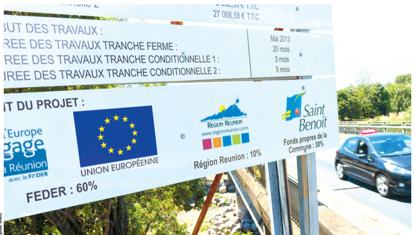
Sur ce chantier, l'Europe finance 60% de l'investissement. Cela donne une idée de la contribution de l'Europe à la création d'emplois à La Réunion.
