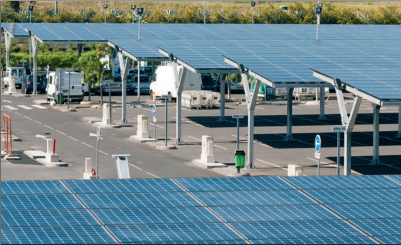
Photovoltaïque à La Réunion. Le secrétaire général de l'ONU rappelle que pour réduire les émissions de gaz à effet de serre, des solutions existent déjà. Elles doivent être développées. (Photo Toniox)
