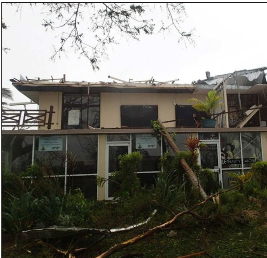
Les bureaux de Care Australia à Port Vila après le passage du cyclone. (photo Care Australia)
