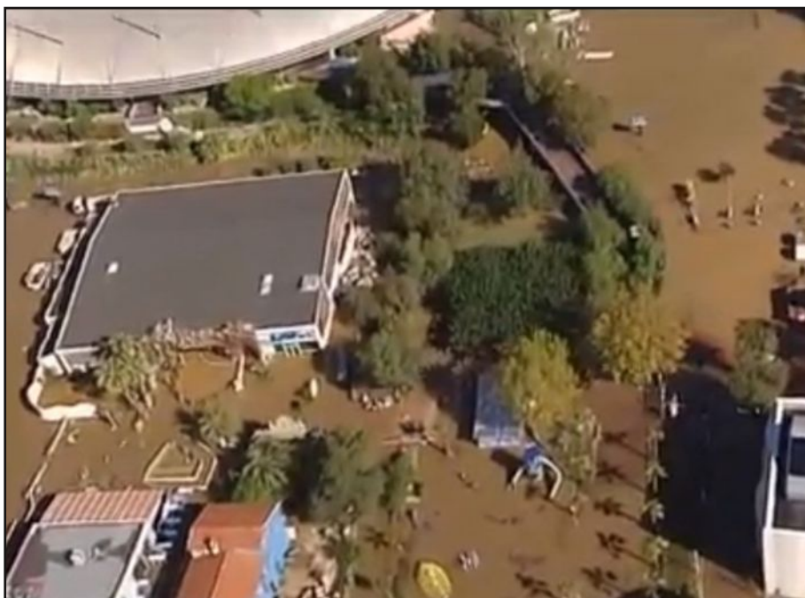
Dégâts des pluies. (Image France 3)
