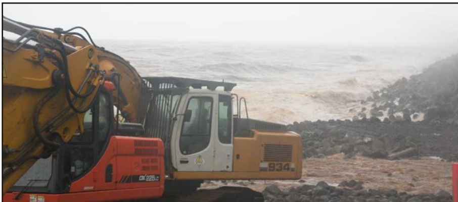
Le chantier de Didier Robert est prévu pour engloutir des fonds considérables, alors qu'il est déjà condamné par la montée du niveau de la mer.
