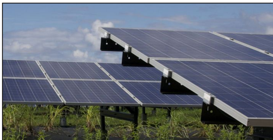
Le photovoltaïque, source d'énergie principale à Mafate.
